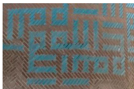
تصویر ۹: تلفیق آجر و کاشی بر روی گنبد مقبره شیخ صفی، (منبع: نگارنده (فاطمه بیدبرگ)، ۱۳۹۶).
