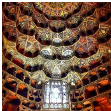
تصویر ۱۳: نمونه‌هایی از گچ‌بری پته در زیر گنبد مقبره شیخ صفی (سمت راست) و گچ‌بری مجوف بصورت مقرنس در عمارت چینی‌خانه (سمت چپ)، (منبع: نگارنده (فاطمه بیدبرگ)، ۱۳۹۶)
