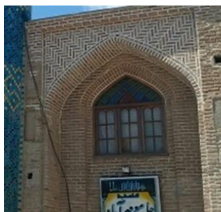
تصویر ۱۰: نمایی از آجرکاری تاق‌نماهای مسجد مهرآباد بناب بصورت خفته و راسته (منبع: www.fishineh.com )
