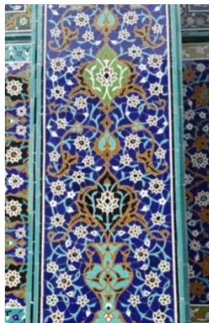
تصویر ۶: نمونه‌هایی از کاشی هفت‌رنگ با نقوش گیاهی و افسانه‌ای چین در ازاره داخلی چینی‌خانه (سمت راست) و کاشی معرق با نقوش گیاهی بر روی تالار دارالحفاظ (سمت چپ)، (منبع: نگارنده (فاطمه بیدبرگ)، ۱۳۹۶).
