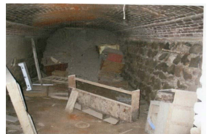
شکل ۷: سنگ در دیوار چینی و سقف قوسی آجری در زیرزمین (همان، ۱۳۹۸)
